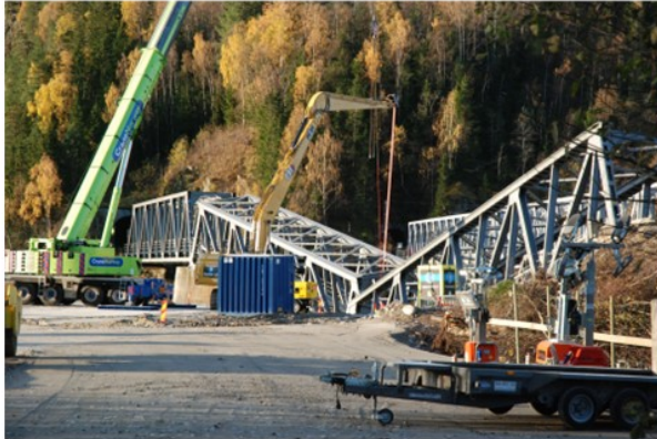
Istandsetting av Randklev jernbanebro høsten 2023. 9,5 mnd. ute av drift
