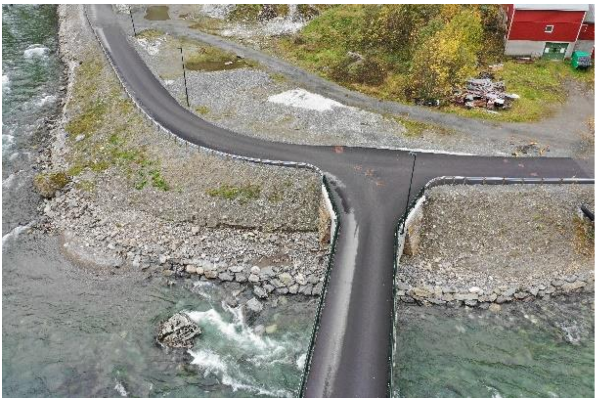
Figur 52. Begynnende erosjon bak forbygningen ndf Leinafoss kraftverk og ovenfor Brekke bru etter høstflommen 2018 (192 m 3 /s, ca. Q10-Q20).
