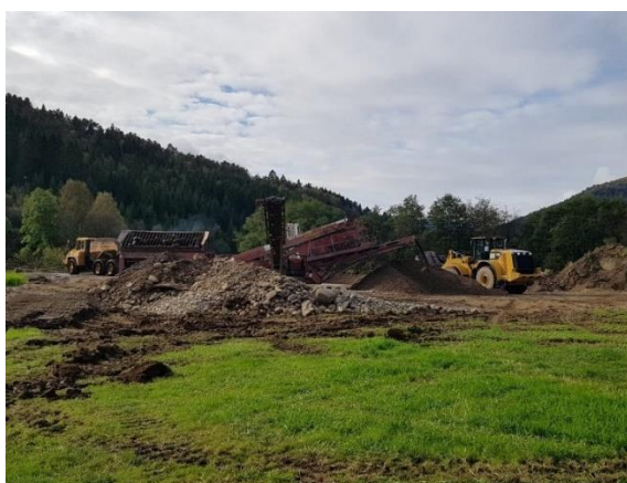
Figur 123. Bilder tatt under arbeidet. Venstre: Utgravde masser siktes i mobilt sikteanlegg. Høyre: Maskiner graver ut finsedimenter og legger tilbake ferdig siktete sedimenter.
