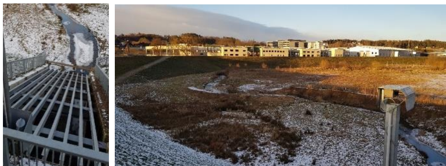
Eksempel fordrøyningsbasseng og spalteformet utløp i Raaba/Østerrike ved normal vannføring.
