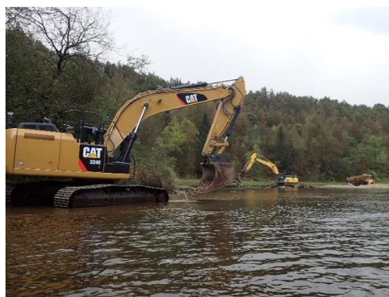
Figur 123. Bilder tatt under arbeidet. Venstre: Utgravde masser siktes i mobilt sikteanlegg. Høyre: Maskiner graver ut finsedimenter og legger tilbake ferdig siktete sedimenter.
