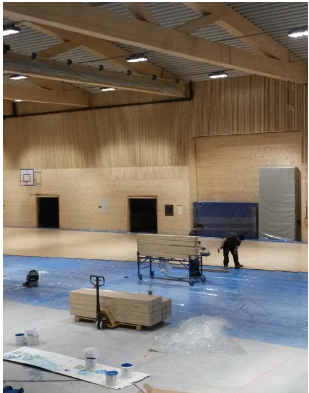
Legging av kombielastisk gulv. Foto: BOEN SPORT
