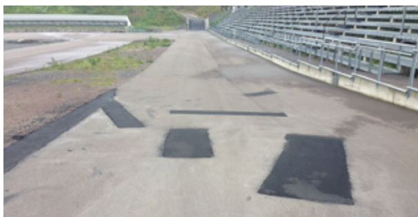
Stykkevis reparasjon av asfalt.
