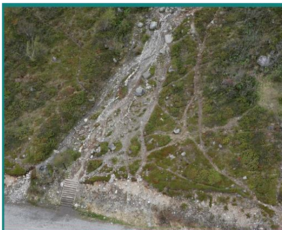
Stien ved Gjendesheim før restaurering 2005
