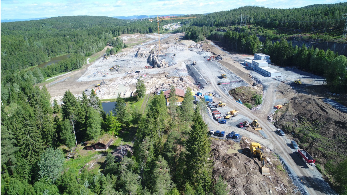
Bilde 2: Kontorbrakker og tårnkran er etablert på Taraldrud
